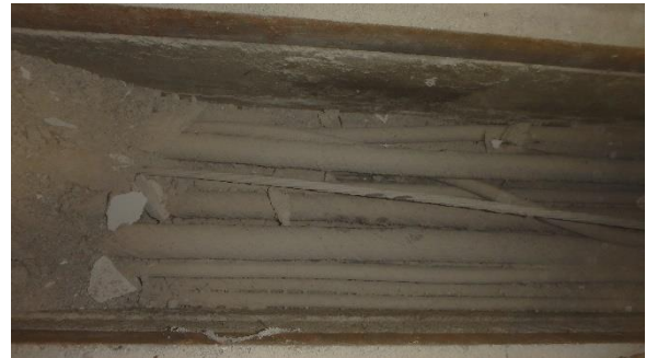
Kaapelissa ohut massakerros (tasoite), jokaKaapeleita ja johtoja on useita alapohjan sisältää asbestia. Putket huonokuntoisia tekniikkakanaaleissa
