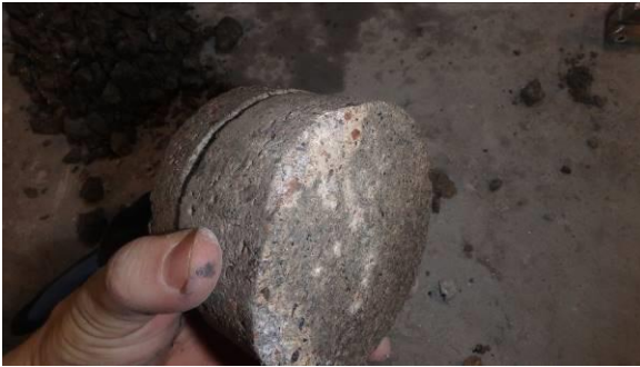
ASB.88: vanhan pintalaatan päällä laasti- jäämiä
