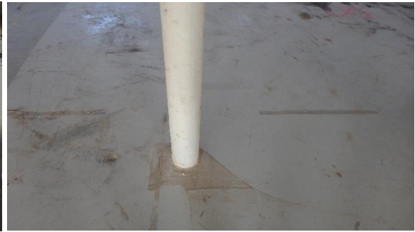
Yläpohjan (213) laudoituksen maali sisältää Puuyläpohjaa (213) kannattavien valurautapilarien maalissa on vaarallista jätettä
