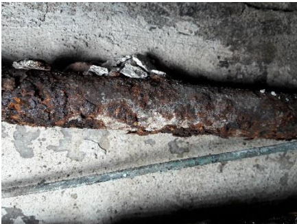
Kaapelissa ohut massakerros (tasoite), jokaKaapeleita ja johtoja on useita alapohjan sisältää asbestia. Putket huonokuntoisia tekniikkakanaaleissa
