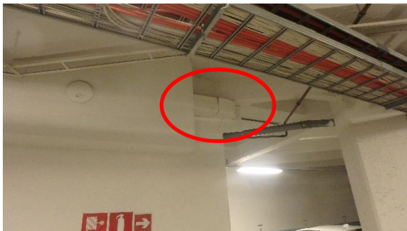
Asbestisementtikanavaa
