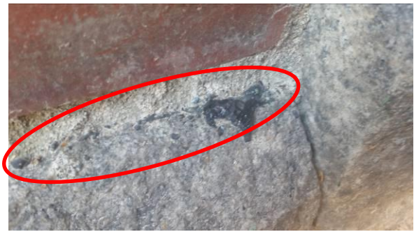
Sokkelin kiviverhouksen ja tiilimuurauksen liitoksessa on käytetty kosteudeneristeenä kivihiilipikeä
