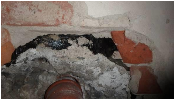
Rakennuksen 213 laajennusosan sisämuu- Rakennuksen 213 laajennusosan (1938) rauksen takana oleva bitumihuopa ja -sivelybitumikermi kaksoislaatan välissä väestönsuojan tiloissa sisältävät asbestia
