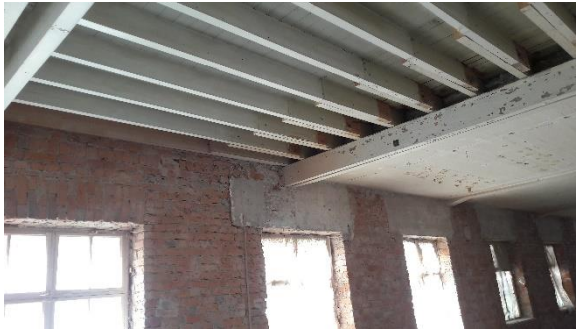
Yläpohjan (213) laudoituksen maali sisältää Puuyläpohjaa (213) kannattavien valurautapilarien maalissa on vaarallista jätettä
