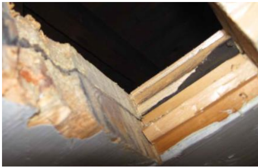
Rakennuksen 213 yläpohjassa on käytetty tervapahvia (kuva Optiplan 2016)
