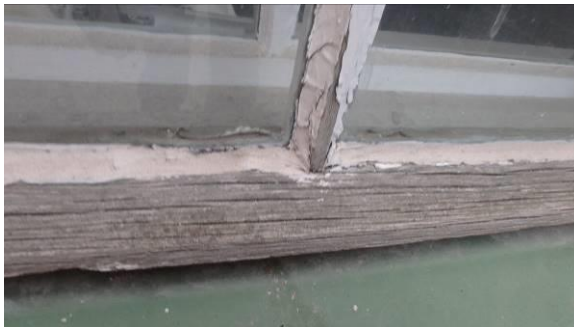
Ikkunamaali ja -kitti (214) sisältävät vaarallista jätettä Porrashuoneen (214) käytävän maaleissa vaarallista jätettä
