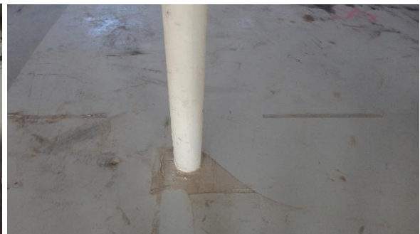
Puuyläpohjaa kannattavien valurautapilarien maalissa on vaarallista jätettä
