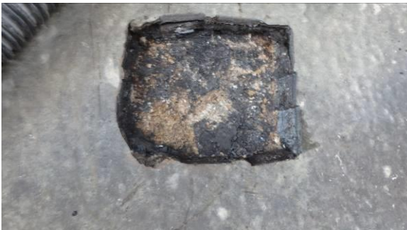
Osassa kattilahuoneen kermeissä todettiinYleiskuva käytävän vesikatteesta asbestia
