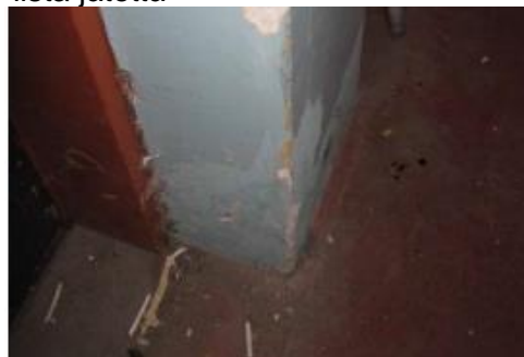
Jätekatoksen (214) maaleissa myös vaarallista jätettä Ikkunapenkin maaleissa vaarallista jätettä. (kuva Optiplan 2016)
