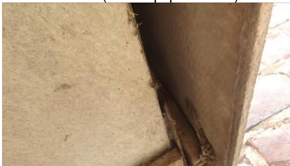
Kiviaineslevyä on käytetty myös tuulensuojalevynä julkisivulevyn ja koolauksen alla
