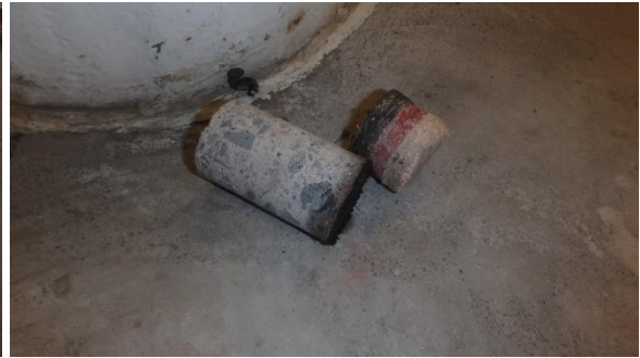
ASB.90: lattian pintamassoja kahtena ker- roksena
