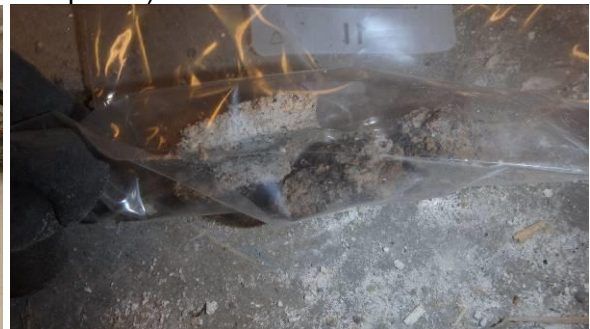
ASB.85: lattian alkuperäisiä pintamassoja
