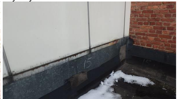
Vastaavaa rakennetta on käytetty tavarahissin seinissä
