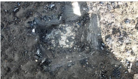
Vesikaton kermeissä on asbestia. KermejäYleiskuva vesikatoista 213 ja 215 on useita kerroksia.
