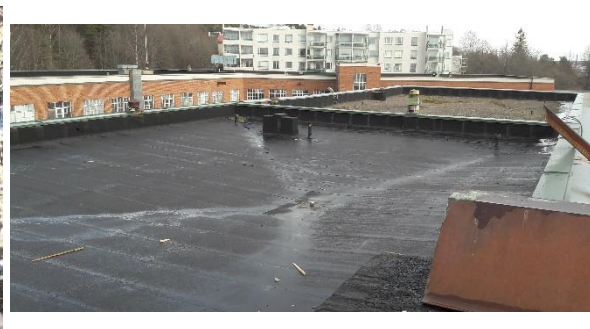
Vesikaton kermeissä on asbestia. KermejäYleiskuva vesikatoista 213 ja 215 on useita kerroksia.
