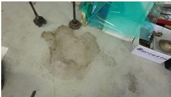
Näyte OL.03 otettiin alueelta, jossa havaittiin öljyhiilivedyt (OL.03) analysoidiin noin 90 mm paksuisesta lieriöstä (pintalaatasta)
