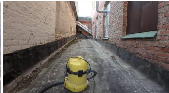
Osassa kattilahuoneen kermeissä todettiinYleiskuva käytävän vesikatteesta asbestia
